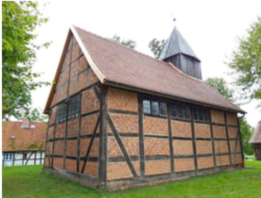
Die neue Dacheindeckung in Wootz
